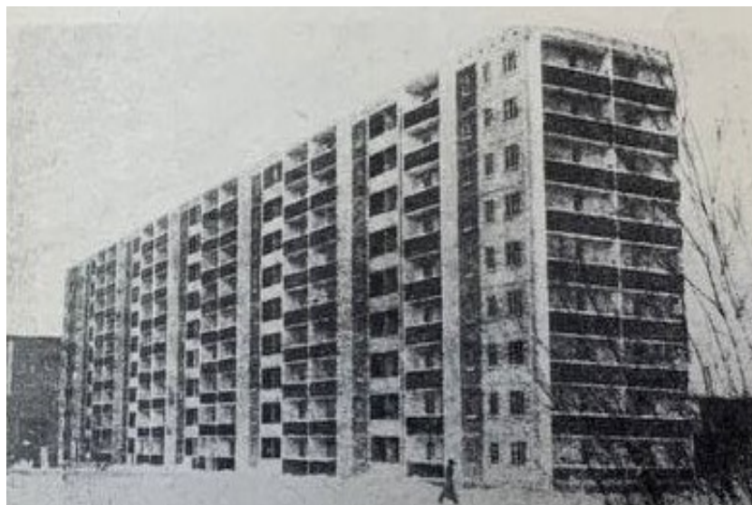
Рис. 2. Девятиэтажное здание серии III-75 с наружными стенами из шунгизитобетона [3]
