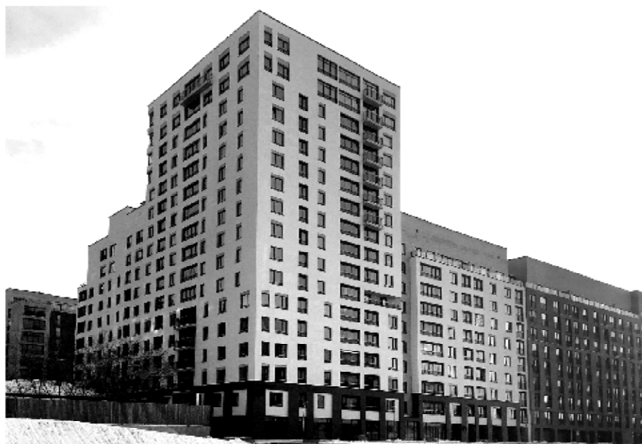
Рис. 3. Жилой дом на Декабристов, 41, 3-я очередь строительства, 2017 г. (иллюстрация автора)
