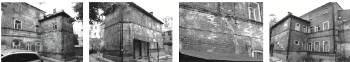
Рис. 6. Общий вид технического состояния конструкций наружных стен в зонах примыкания пристроев к основному корпусу жилого дома.
