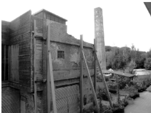
Рис. 9. Старый производственный корпус с восстановленной трубой (иллюстрация авторов)
