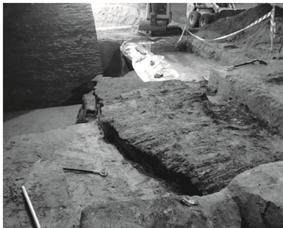
Рис. 7. Фрагмент несущего остова деревоземляного бастиона (строительство 1703 г.)
