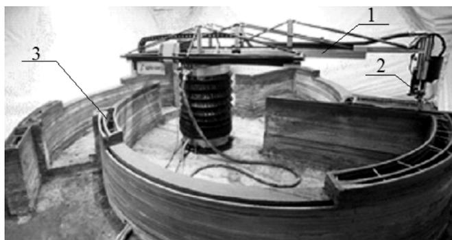
Рис. 4. Мобильный строительный 3D-принтер ArisCor, работающий в угловых координатах:
