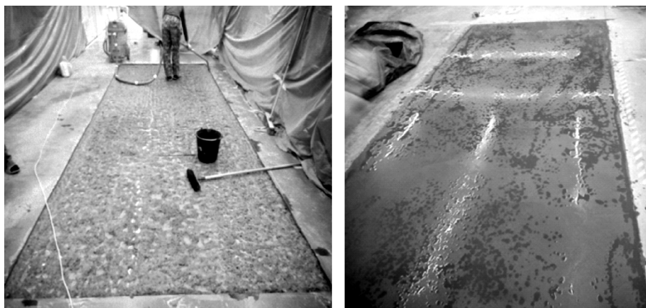
Рис. 2. Фотоснимки процесса ремонта поверхности промышленного пола с помощью тиксотропных и наливных составов
