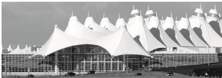
Рис. 1. Тентовое покрытие над аэровокзалом в Денвере (США)
