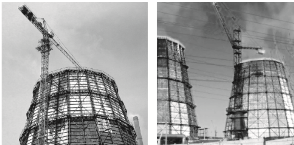
Рис. 1. Общий вид организации монтажных работ
