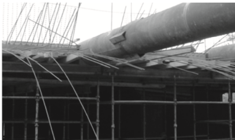
Рис. 6. Установка распорных конструкций из металлических труб
