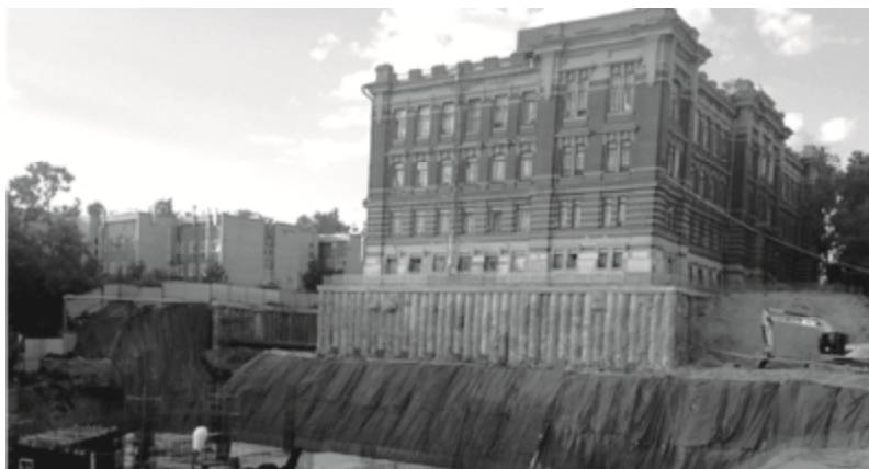
Рис. 5. Разработка грунта в котловане
