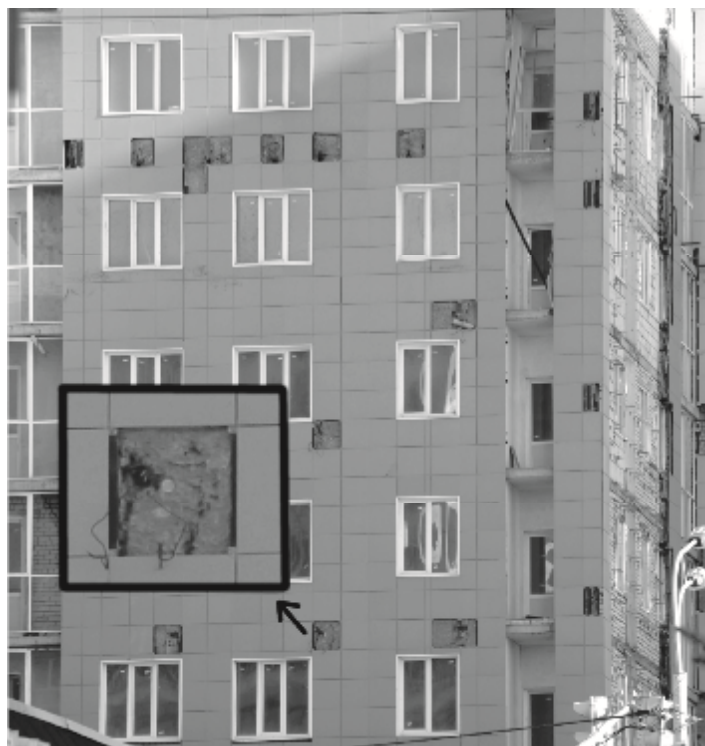
Рис. 3. Разрушение утеплителя уже на этапе строительства
