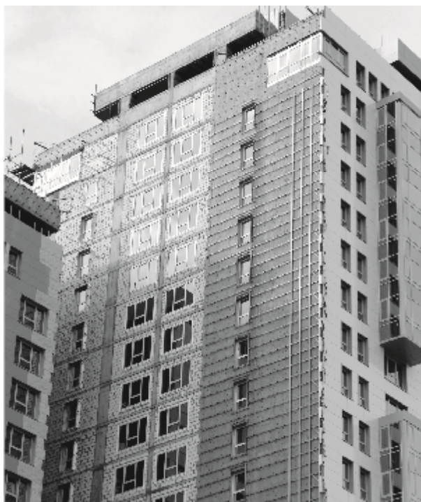
Рис. 1. Пример современной ограждающей конструкции с использованием минеральной ваты
