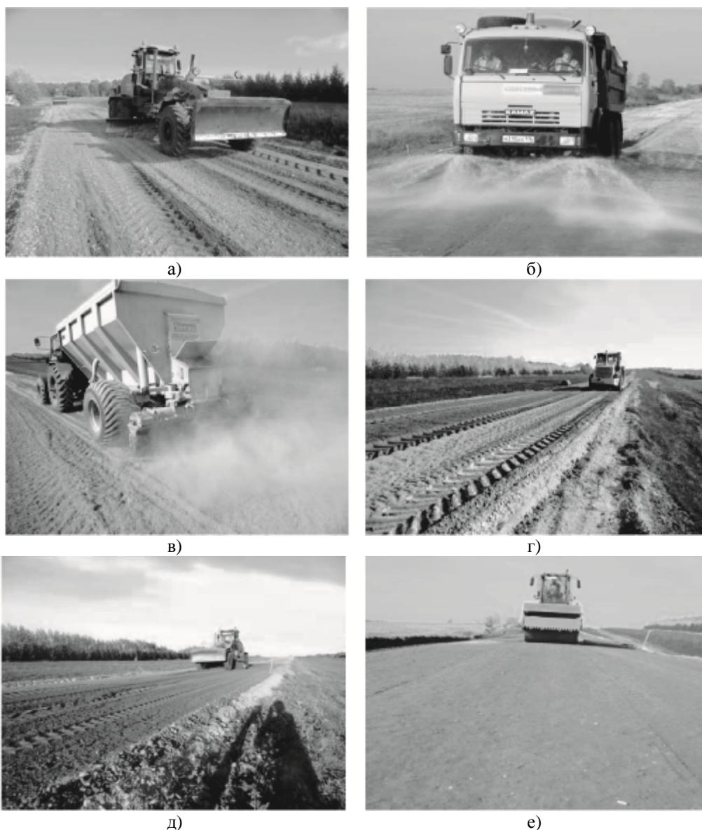
Рис. 2. Основные технологические операции по устройству дорожной одежды на экспериментальном участке:
