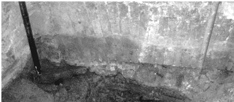
Рис. 5. Разгрузочная арка [1]
