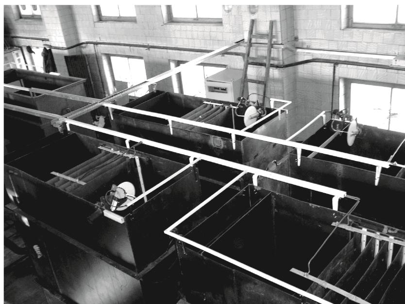
Рис. 2. Модульные установки электронейтрализационной очистки на Мурманской ТЭЦ
