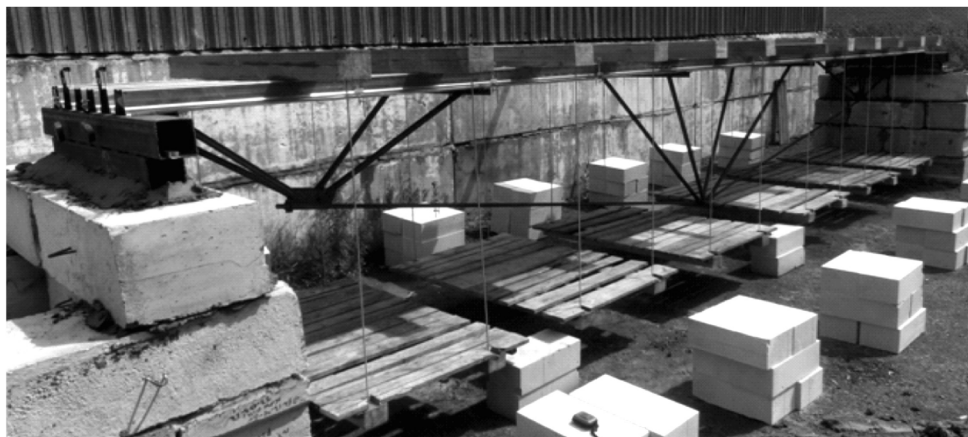
Рис. 1. Общий вид испытываемой конструкции
