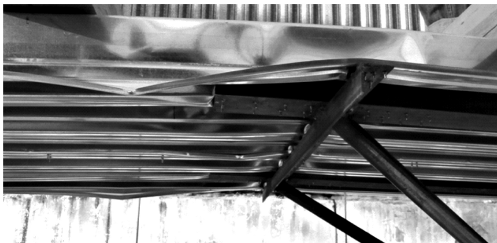
Рис. 7. Разрушение плиты у правой пирамиды (потеря местной устойчивости сжатых стенок и полок) на 9-ом этапе нагружения ( 673 \text{ кг/м}^2 )
