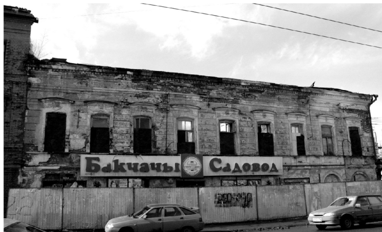
Рис. 4. Общий вид здания вдоль улицы Московская
