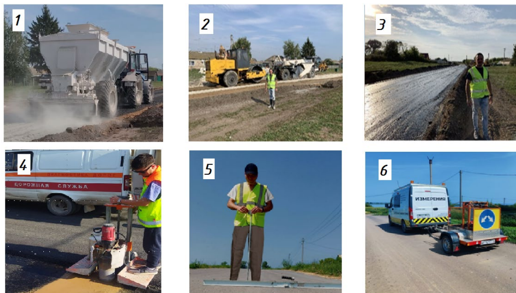
Рис. 4. Фото технологических операций по строительству цементогрунтовых оснований и последующего мониторинга состояния дороги: 1) Распределение портландцемента и активированного наполнителя (на участке с комплексной модификацией) по уложенному слою грунта; 2) Перемешивание компонентов ресайклером и уплотнение основания катком; 3) Уход за уложенным слоем – розлив битумной эмульсии; 4) Отбор кернов; 5) Определение поперечной ровности; 6) Определение модуля упругости. (иллюстрация авторов)
