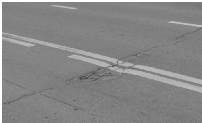
Рис. 2. Разрушение покрытия проезжей части в районе ДШ (иллюстрация авторов)
