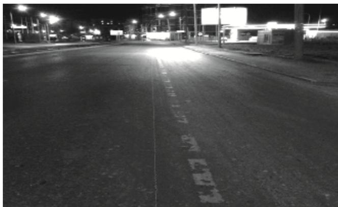
Рис. 2. Пример истираемости горизонтальной разметки
