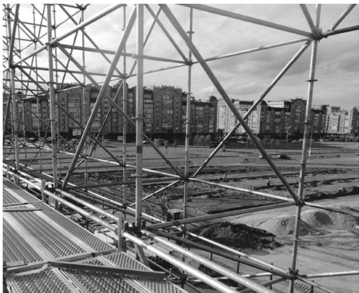
Рис. 1. Фрагмент мобильного стержневого сооружения
