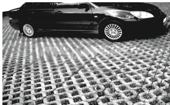
Рис. 3. Устройство экопарковки с использованием газонных решеток
