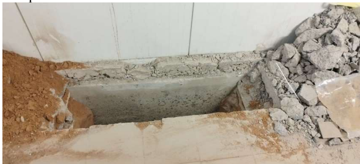
Рис. 4. Общий вид шурфа размерами 0,4х1,4 м (иллюстрация авторов) Fig. 4. General view of a 0.4 x 1.4 m test pit. (illustration by the authors)
