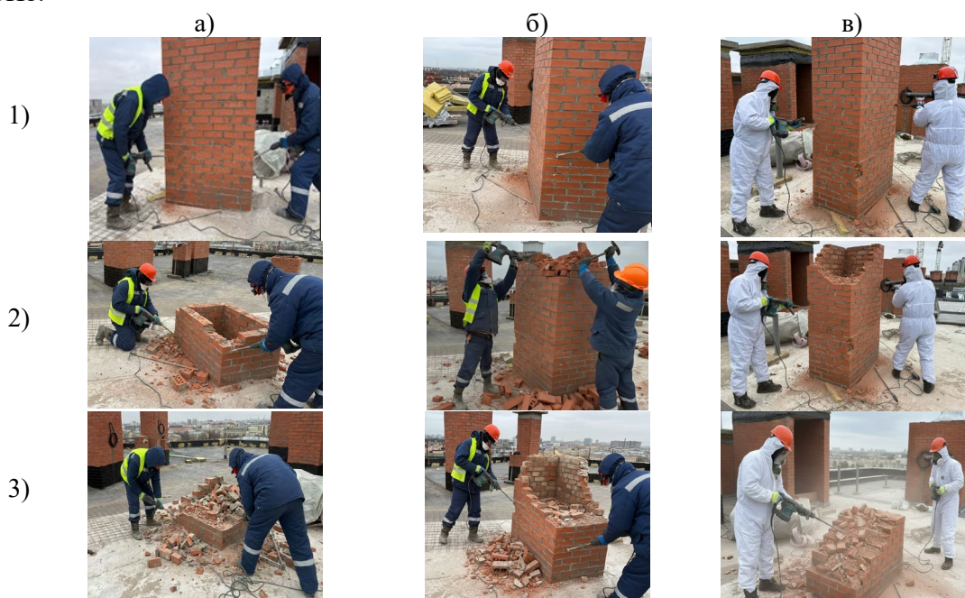
Рис. 2. Фотофиксация работ по разборке стен из мелкокоразмерных элементов поэтапно 1-й ряд – в начале работы, 2-й – в процессе, 3-й – в конце работ в различных условиях производственной среды: а) в обычной; б) в вредной; в) опасной (иллюстрации автора)
