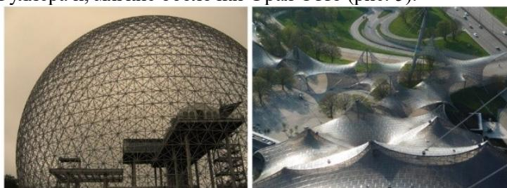
Рис. 5. Геодезические купола и мягкие оболочки
