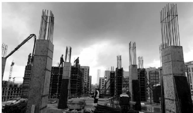
Рис. 1. Фотография распалубленных конструкций после 72 ч. температурной обработки (иллюстрация авторов)
