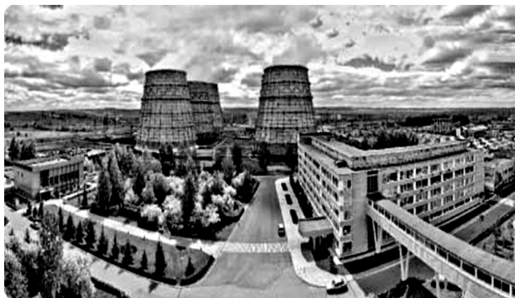
Рис. Вид обследуемого производственного здания Теплоэлектроцентрали в г. Набережные Челны ( http://chelny-week.ru/2013/11/ctanciya-nashej-zhizni/ )
