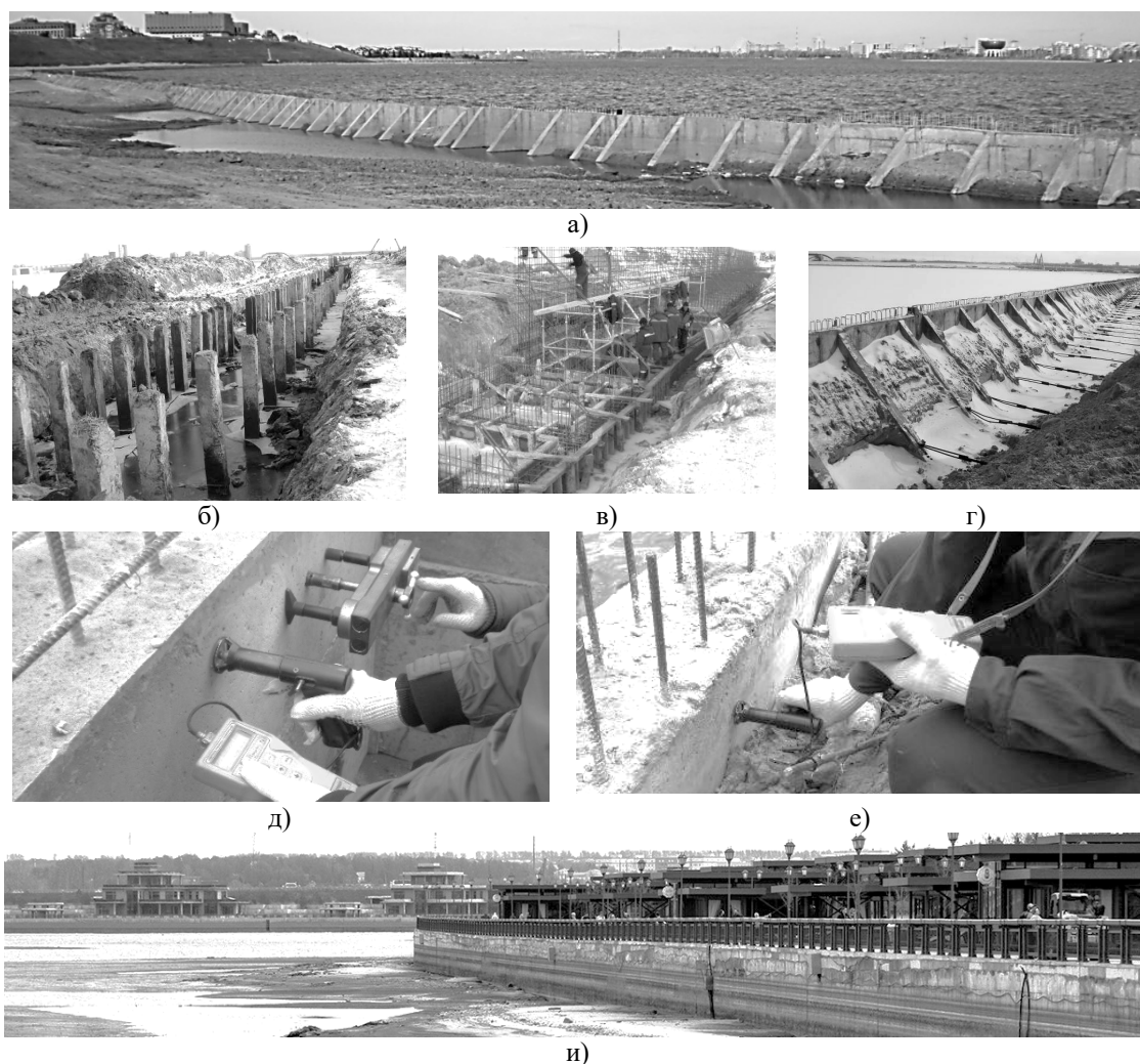
Рис. 8. Берегоукрепительная подпорные стены вдоль акваториальной зоны реки Казанки (иллюстрации автора): а) общий вид конструкции подпорной стены с контрфорсами; б) сваи, погруженные вдоль берега Казанки; в) возведение монолитного железобетонного ростверка и подпорной стены с контрфорсами; г) подпорная стена с анкерными тягами, удерживаемая анкерной плитой; д, е) инструментальное обследование конструкций подпорной стены; е) общий вид и нормальное техническое состояние конструкций подпорной стены со стороны Казанки по состоянию на 2019 г.
