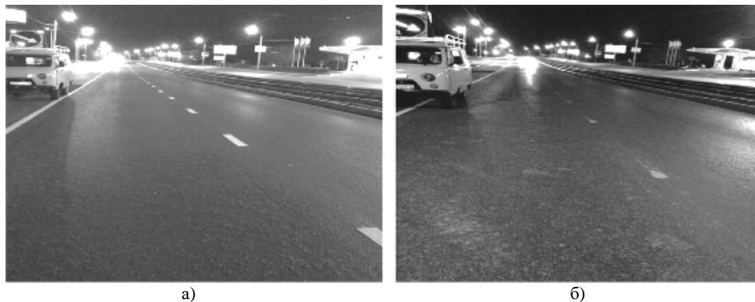
Рис. 2. Дорожная разметка, нанесенная краской: а) первоначальное состояние разметки; б) разметка после двух месяцев эксплуатации
