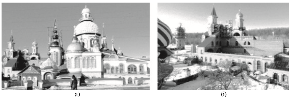
Рис. 2. Общий вид комплекса зданий и сооружений «Храма всех религий» по состоянию на 2017 г.: а) вид на храм со стороны реки Волги; б) незавершенная строительством часть комплекса
