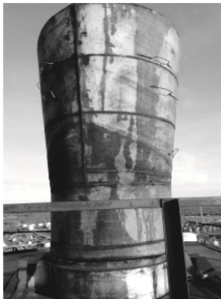
Рис. 2. Установленный диффузор газоотводящего ствола
