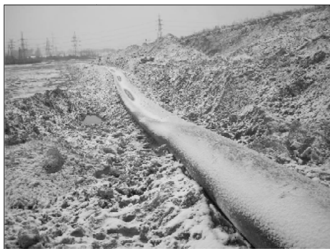
Рис. 2. Участок трубопровода подверженный деформированию
