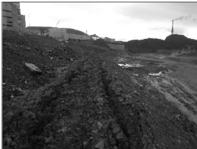
Рис. 1. Проседание грунта на аварийном участке трубопровода
