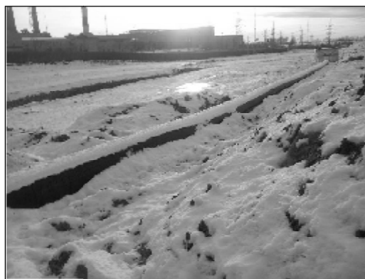
Рис. 4. Восстановленный участок трубопровода
