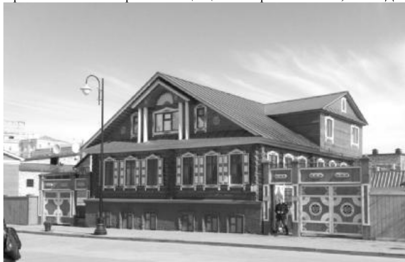
Рис. 4. К. Насыри, 11. Современное состояние после реконструкции
