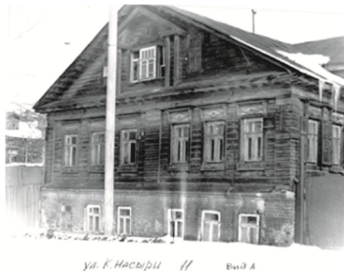
Рис. 2. Жилой дом, К. Насыри, 11. Фотография из архива Управления архитектуры и градостроительства г. Казани
