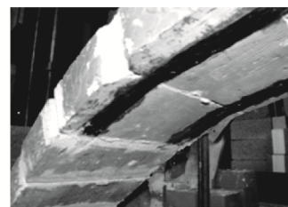
Рис. 5. Усиление нижней поверхности арок УГВ-лентами
