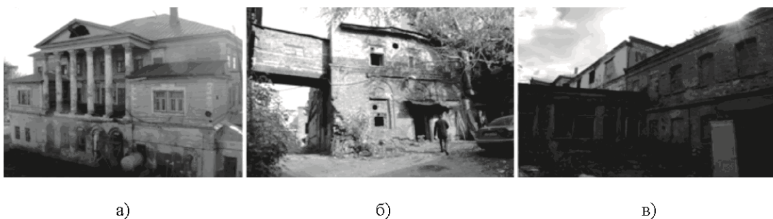
Рис. 8. Современная фотофиксация: а) Дом Котелова (ОКН); б) Кузница; в) Строгальный корпус
