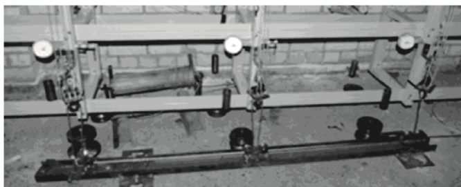
Рис. 2. Прогибомеры, установленные на наружном слое испытываемого фрагмента
