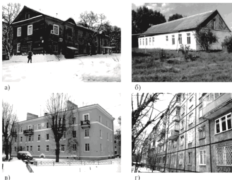
Рис. 3. Примеры домов массовой постройки: а, б – деревянный барак начала XX века; в – кирпичное здание с деревянными перекрытиями 30-40-х годов; г – крупнопанельное здание 40-50-х годов
