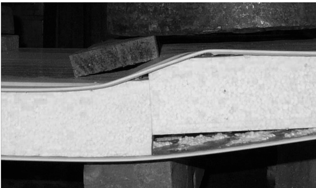
Рис. 2. Разрушение заполнителя в области стыка, расположенного в приопорной зоне
