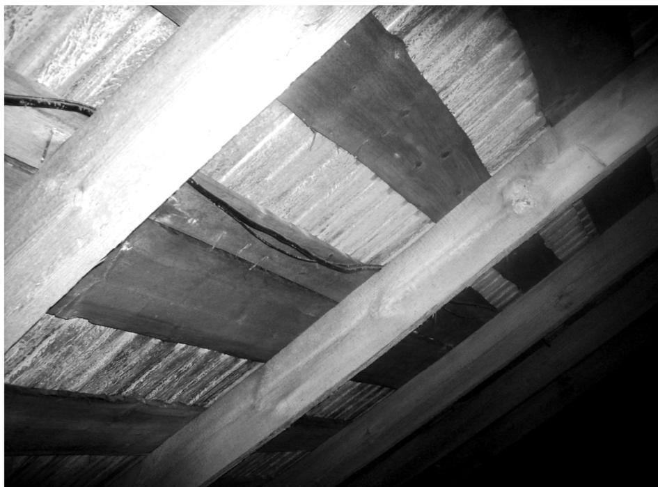
Рис. 1. Общий вид здания, стропильные конструкции кровли в составе обрешетки и стропильных ног из досок 170x50 мм, расположенных с шагом 1,1 м
