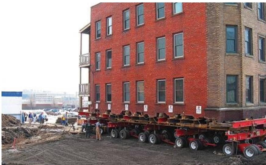
Рис. 3. Перенос здания с применением платформы на колесном ходу, Бостон, США
