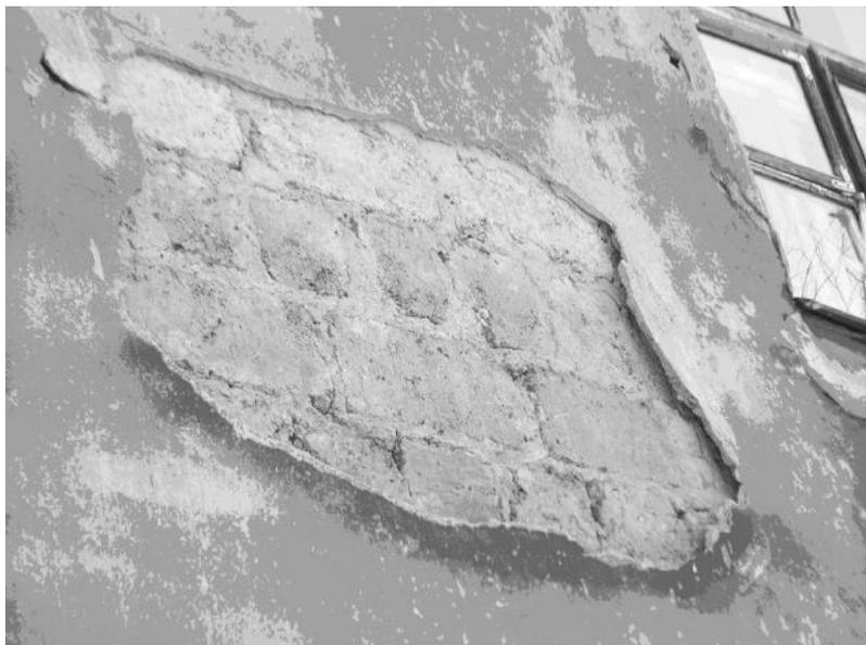
Рис. 8. Несмотря на постоянное отслоение наружной штукатурки наблюдается хорошее состояние гипсобетонных блоков (фото 2008 г.)
