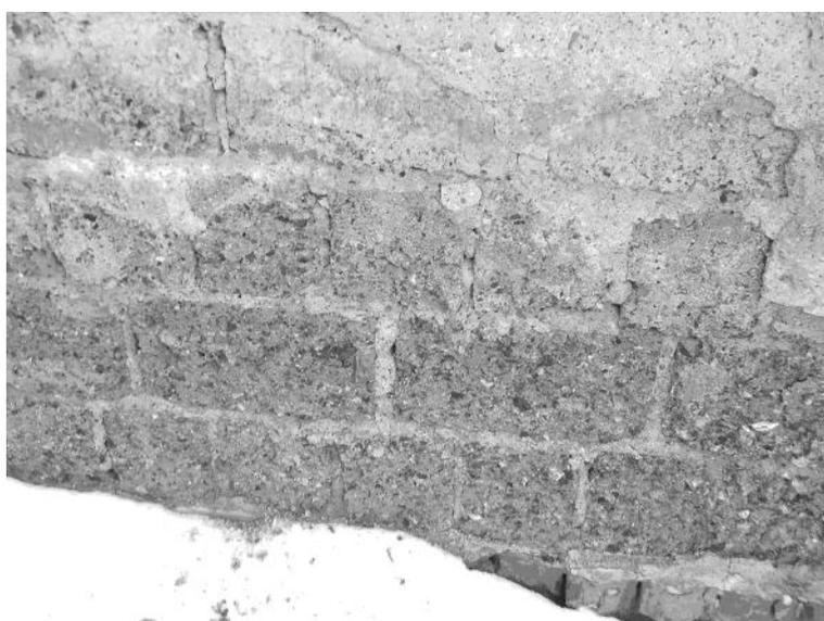
Рис. 9. Цокольная часть дома по ул. Нежинской. Несмотря на постоянное промораживание и воздействие атмосферной влаги за более чем 60 лет эксплуатации дефекты минимальны. Виден состав гипсобетонных блоков с заполнителем на основе топливных шлаков местных котельных
