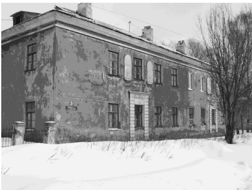
Рис. 7. Жилой дом по ул. Нежинской (фото 2008 г.).
