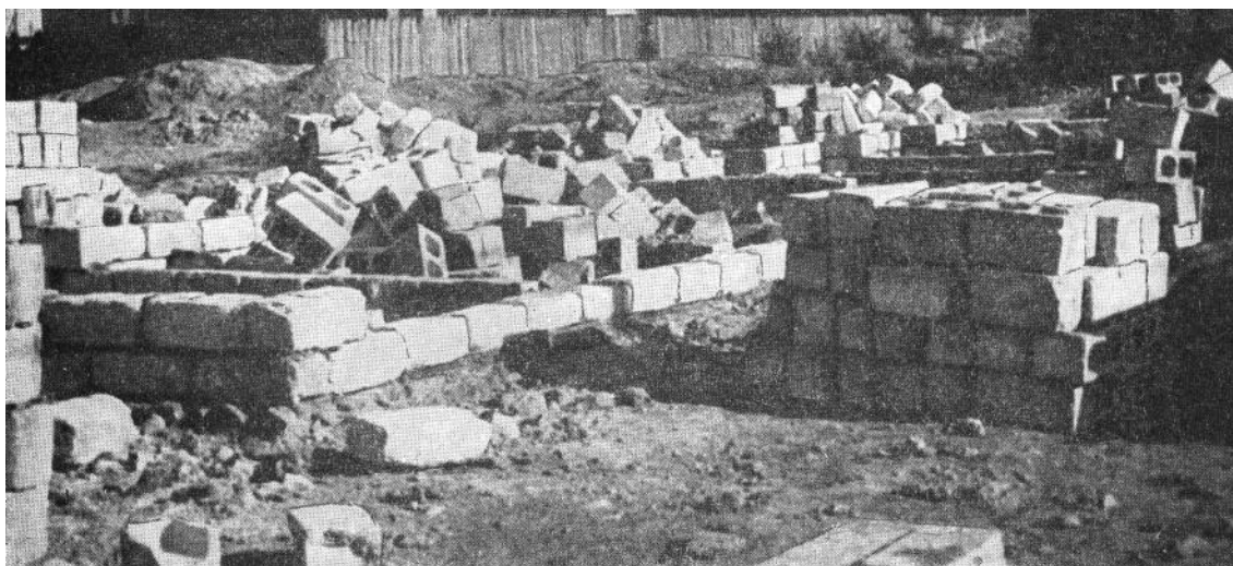
Рис. 1. Мелкоштучные гипсобетонные вибропрессованные блоки на строительной площадке (фото 1951 г.)
