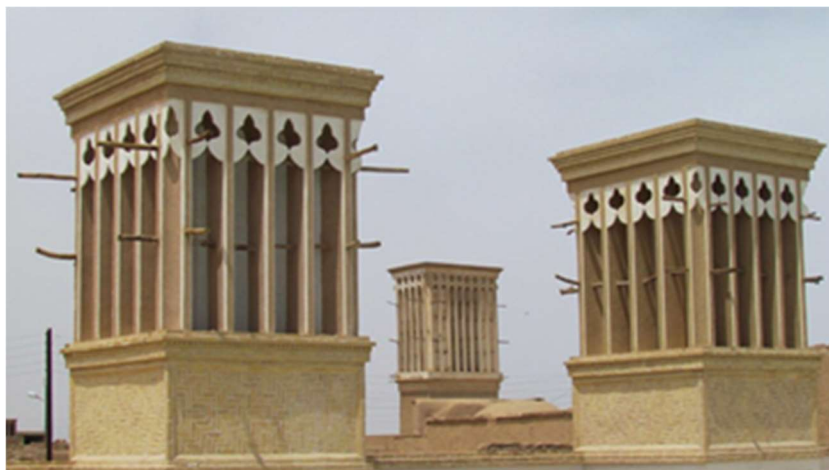
Рис. 5. Воздушные башни, Аль-Малакаф (Бадгир) (Источник: https://clck.ru/3RrdHb ) Fig. 5. Air Towers, Al-Malakaf (Badgir) (Source: https://clck.ru/3RrdHb )
