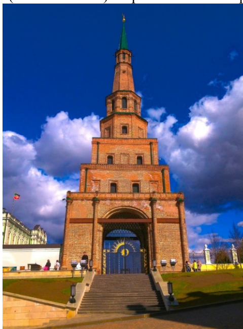
Рис. 1. Башня Сююмбике Казанского Кремля. Памятник архитектуры всемирного значения. Диапазон датировки: п. пол. XVI- рубеж XVII- XVIII вв.. Архитектурная структура состоит из трех четвериков, четырех восьмеников и шатровой крыши. Тип соответствует башенным многоугольно-ярусным надвратным минаретам.
