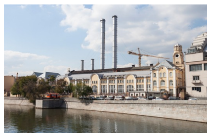
б). Объект до начала работ по реставрации.
