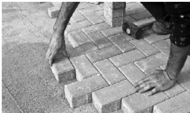
Рис. 2. Укладка тротуарной плитки ручным способом (г. Казань) [4]
