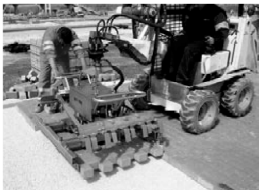
Рис. 3. Укладка тротуарной плитки специальной машиной [6]
