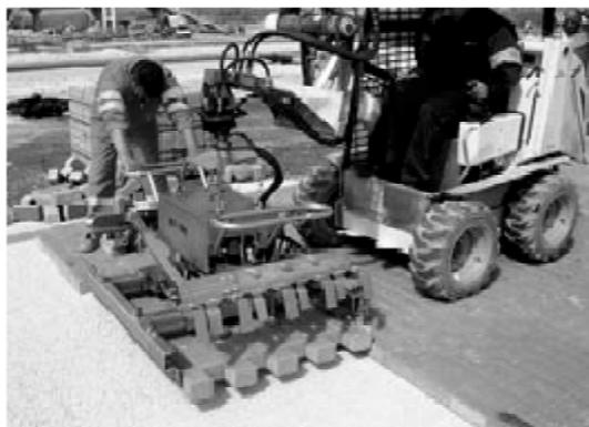
Рис. 3. Укладка тротуарной плитки специальной машиной [6]
