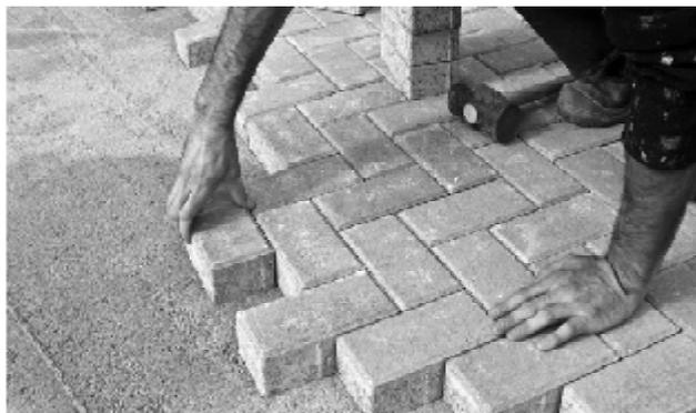
Рис. 2. Укладка тротуарной плитки ручным способом (г. Казань) [4]
