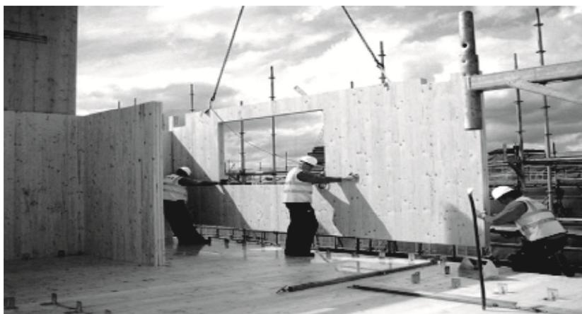
Рис. 2. Процесс монтажа CLT-панели
