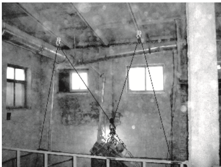
Рис. 2. Демонтаж технологического оборудования по технологии бескранового монтажа
