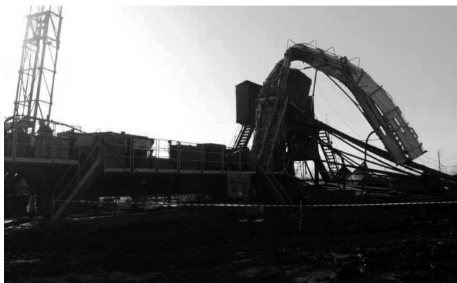
Рис. 3. Общий вид буровой установки после разрушения мачты
