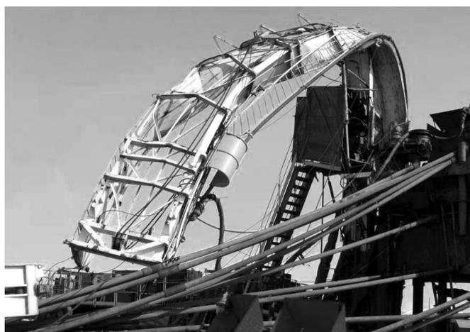
Рис. 4. Состояние элементов решетки верхнего конца нижней секции после разрушения
